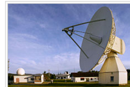
Fundamentalstation Wettzell mit dem 20-m-Radioteleskop. Links Kuppel für Satellitenkamera, hinten für Laserteleskop.
